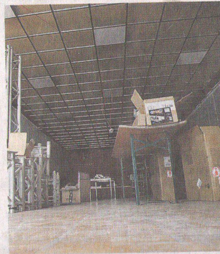
Baustelle. Blick in den Mehrzweckanbau, der ein Loungekino werden soll.
